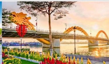
สะพานมังกร
