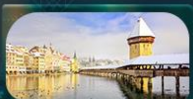
สะพานไมซ์าเปค
