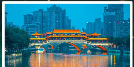
สะพานอันชุน
