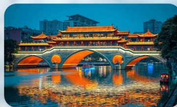
สะพานอันชุน
