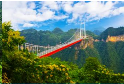
สะพาน ไร่จ้ายต้าเจียว
