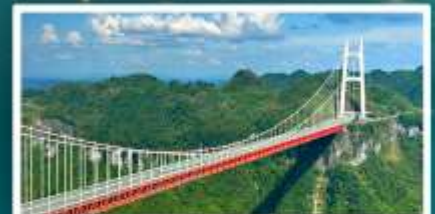
สะพานอ้ายจ้าย
